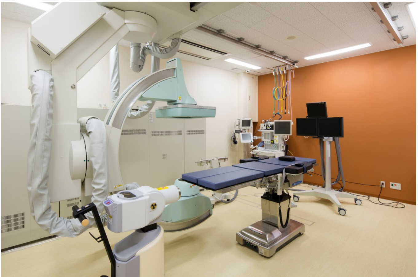
本館地下3階小線源治療室
