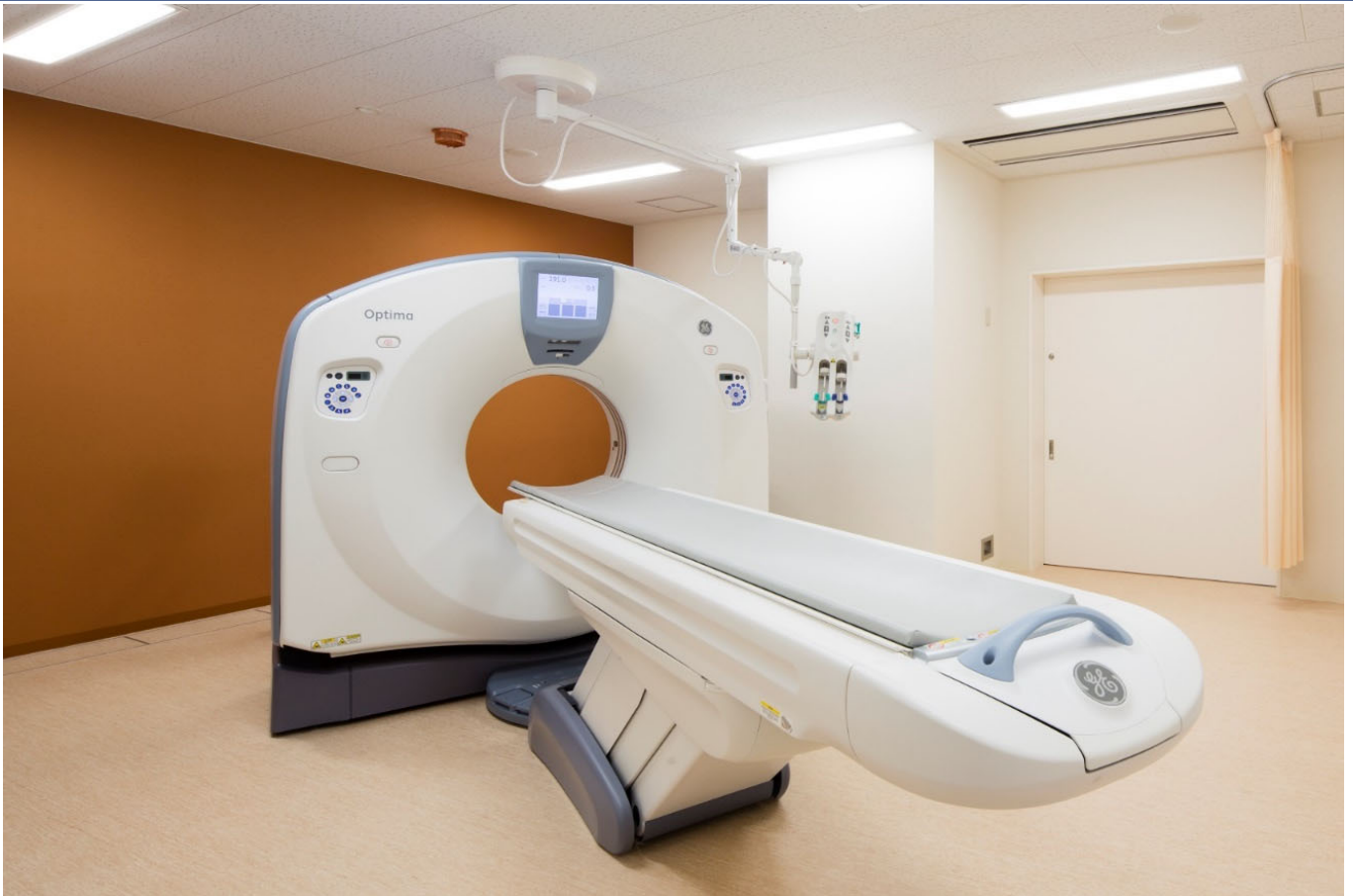
本館地下1階CT室
