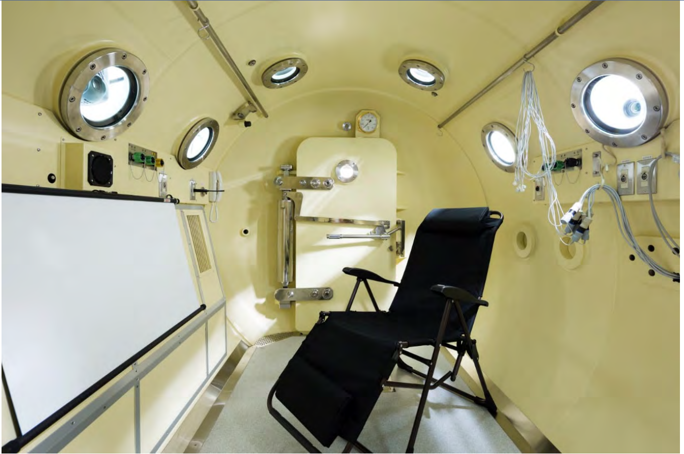
本館地下2階高気圧酸素治療室
