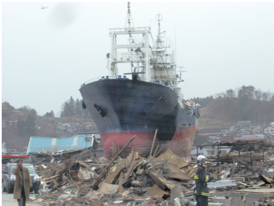
写真1 宮城県気仙沼市 市街地に打ち上げられた船 3月20日撮影
