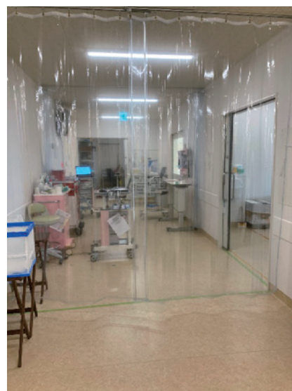
図6 新病院 ICU 個室3室をビニールカーテンで遮閉して重症感染者治療室とした
