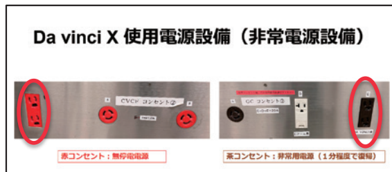
図1 Da Vinci用 3P コンセントの増設（引きかけ式からロック式への変更）
